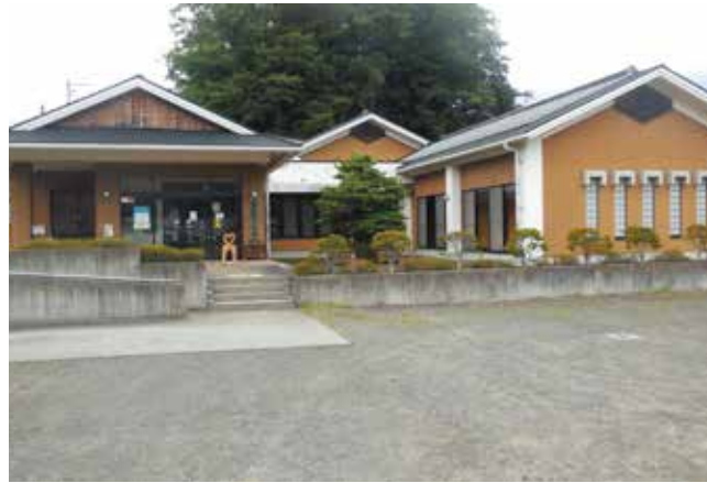
大規模改装される石戸地区交流館
