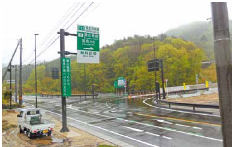
完成した霊山飯館インター
