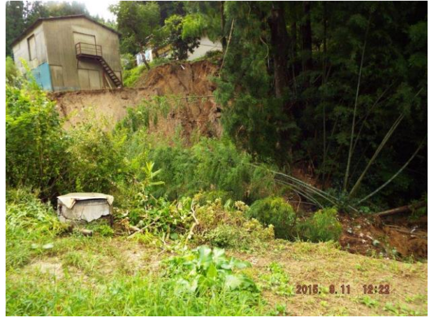
馬館地区 住宅地の土砂崩れ
