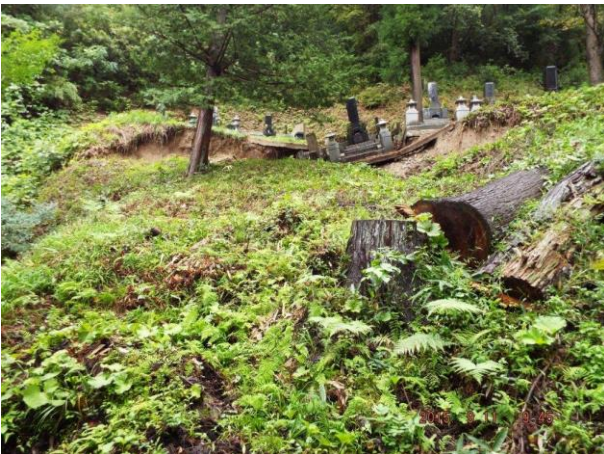
北窪地区 お墓の手前の土が崩れて傾いた
