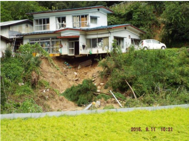
小石田地区 東 住宅地の基礎 庭先が崩れた
