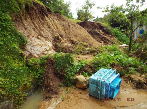
岩崎地区 裏山の農道崩れて住宅地まで
