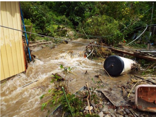
東部地区 住宅地の排水路が詰まって水があふれた 庭全面
