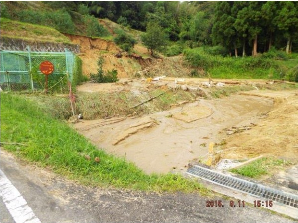
谷田岸地区 山の土砂崩れ 桃畑の土砂が水田に流れるこむ
