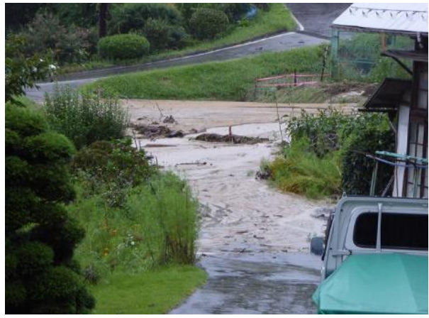
谷田岸地区 土砂が宅地まで迫っている
