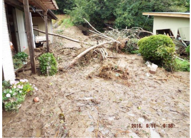
北窪地区 裏山が崩れて住宅地まで土砂が侵入
