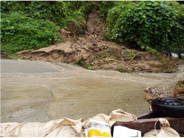
北窪地区 住宅前の畑崩れ
