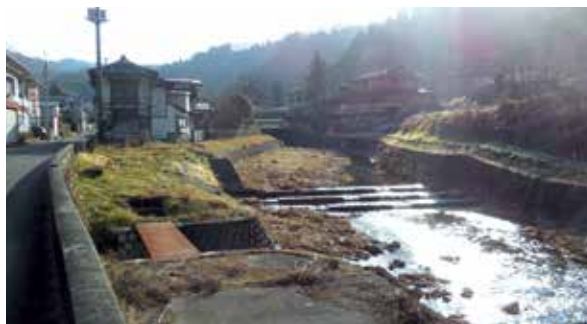
堆砂土砂撤去される石田川
