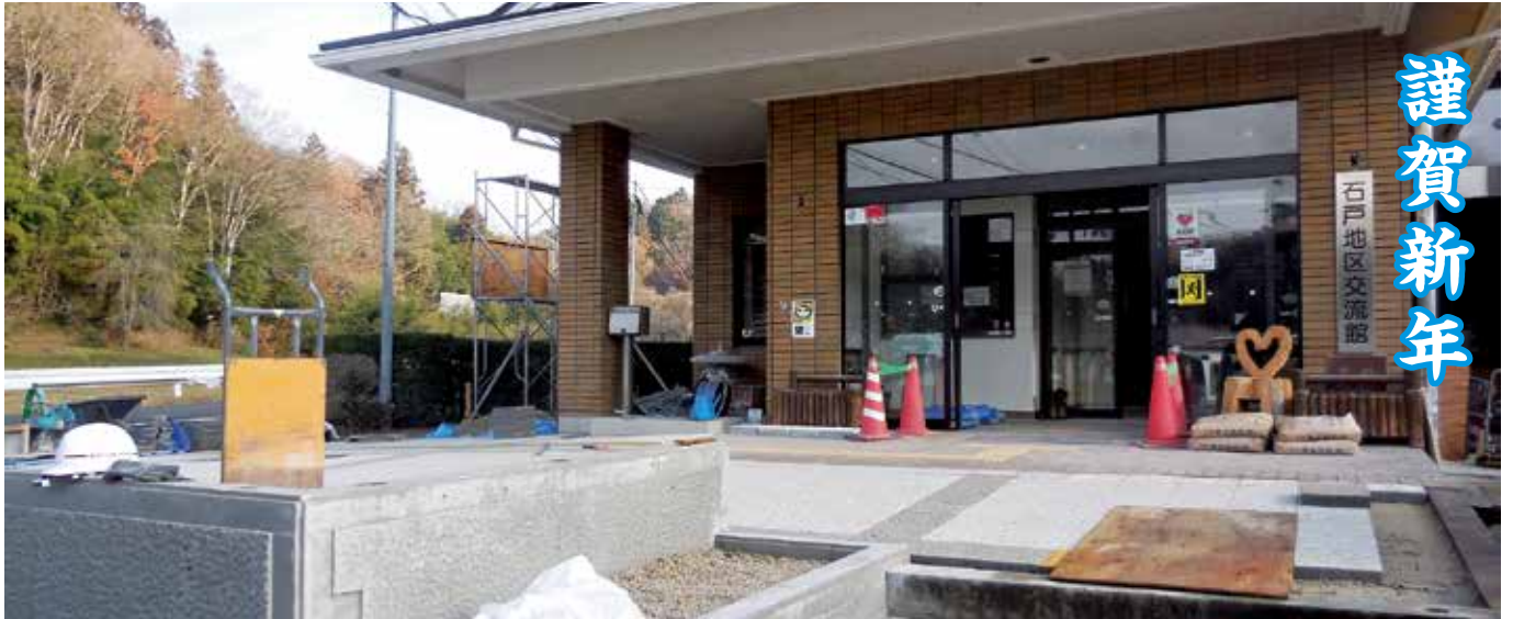
三月完成に向け改装中の石戸地区交流館
